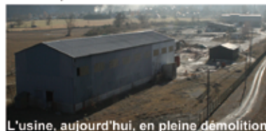
L'usine, aujourd'hui, en pleine démolition
